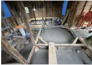
▲コンクリ打設
