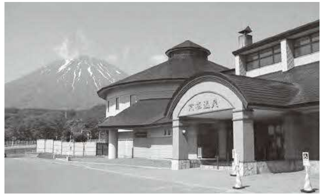
改修工事が実施される京極温泉
