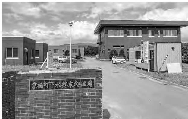
汚泥脱水機を導入予定の「京極町下水終末処理場」
