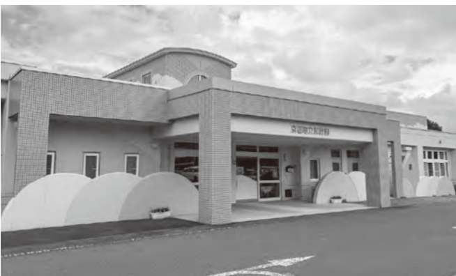
冷暖房設備工事をする「京極町立保育園」
