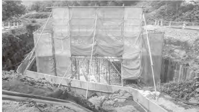
町道松川9号線の工事現場
