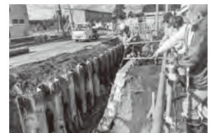
旭川護岸整備工事
