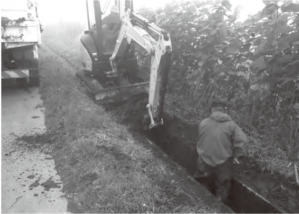
道路側溝整備の様子
