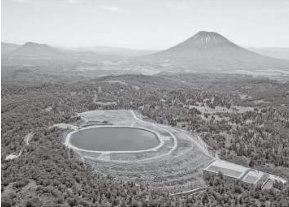
揚水発電所上部池
