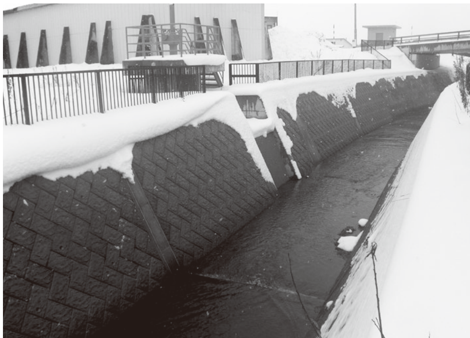
オロツコ川放水路（写真上部が下流、写真中央左がオロツコ川への樋門）
