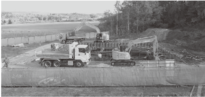
簡易水道浄水場設置工事の現場
