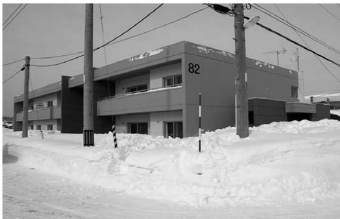
▲平成20年度望羊団地建設工事
