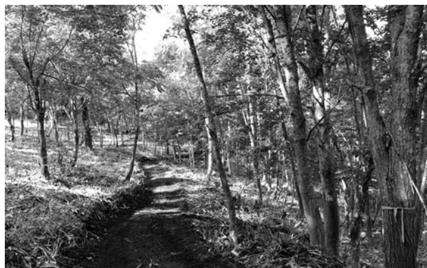
施工直後の森林作業道
