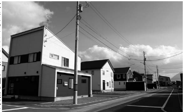
▲前回分譲地（住宅竣工後）
